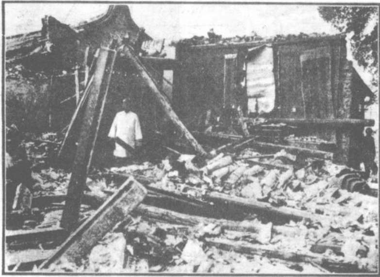
西門外新宮廟地方之情形(圖中一人即當時原狀未遭害)
