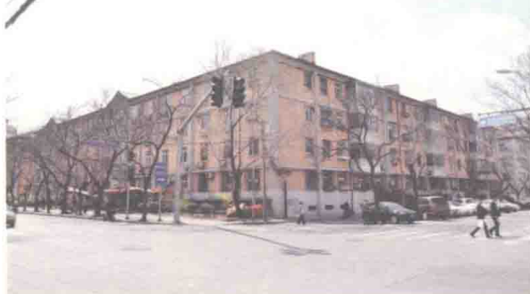
1976年后结构加固的多层住宅
