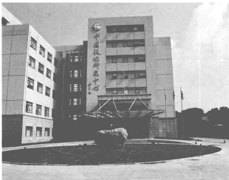
中国极地研究中心办公楼主楼
