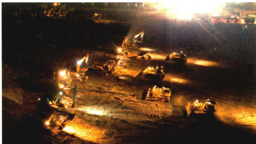
在武汉火神山医院建设工地，大型机械加紧施工。（新华社 肖艺九 摄）
