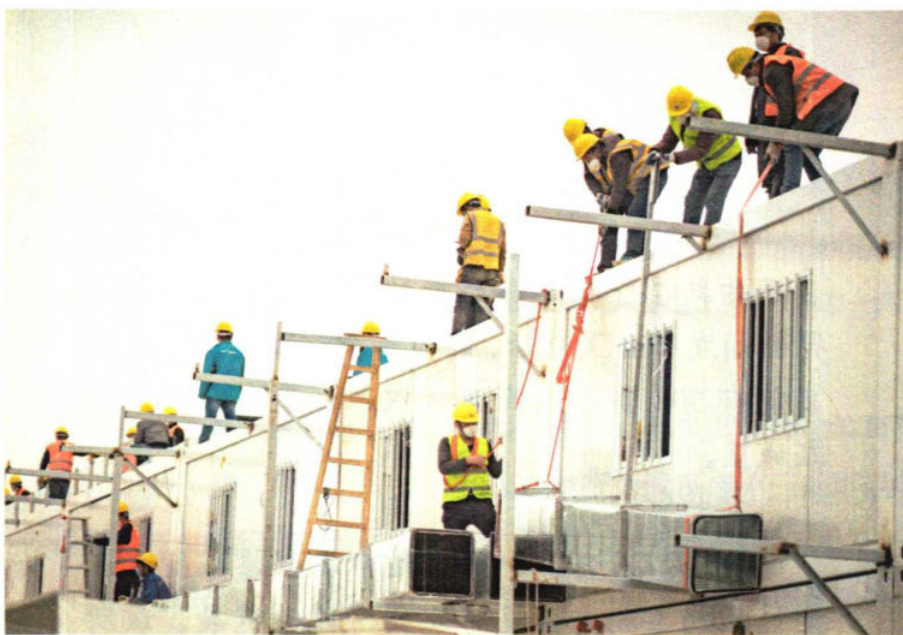
工人在武汉火神山医院建设工地加紧施工(新华社 肖艺九 摄)
