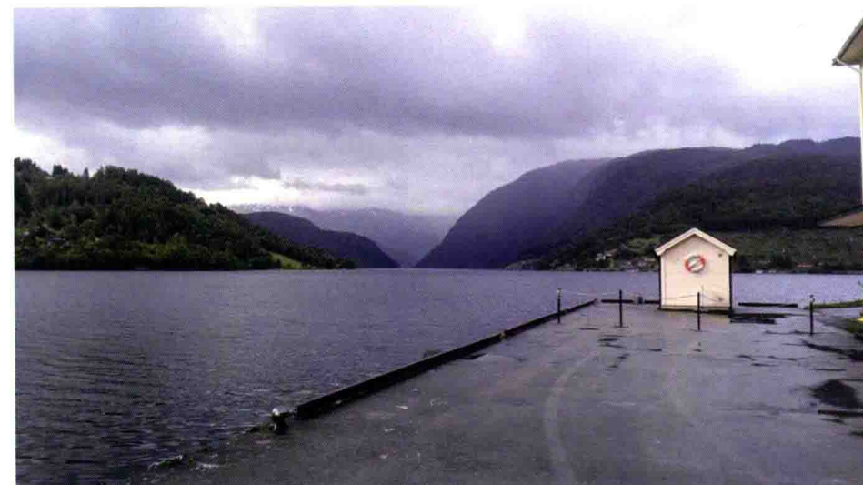
挪威峡湾沿途
