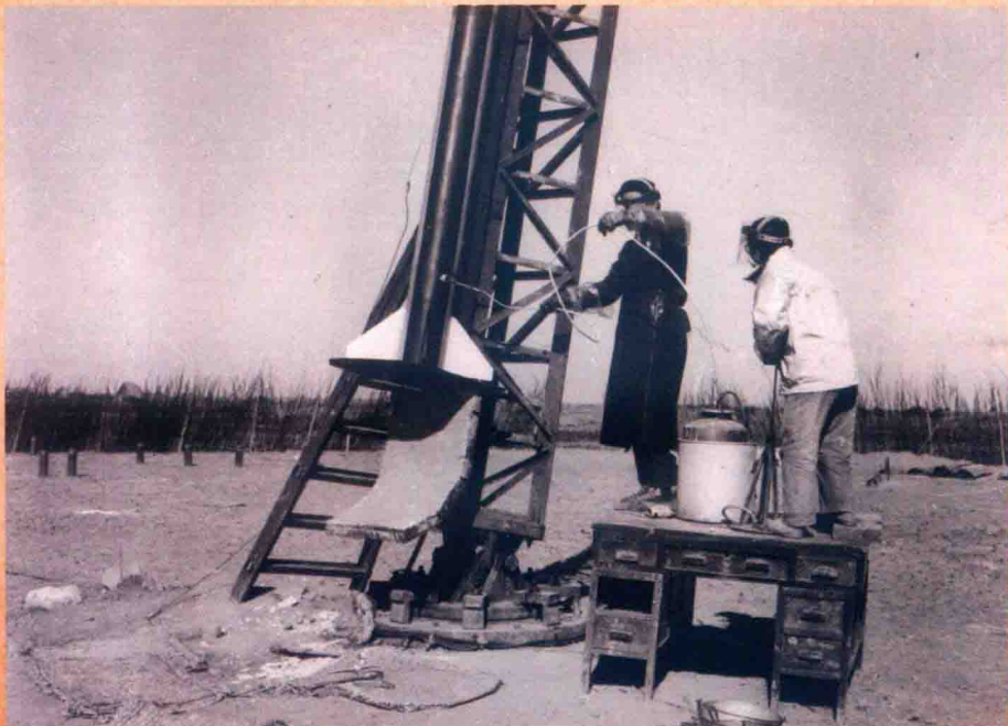
由于缺少专业的加注设备，科研人员只能用自行车打气筒为“T-7M”火箭加注推进剂。
