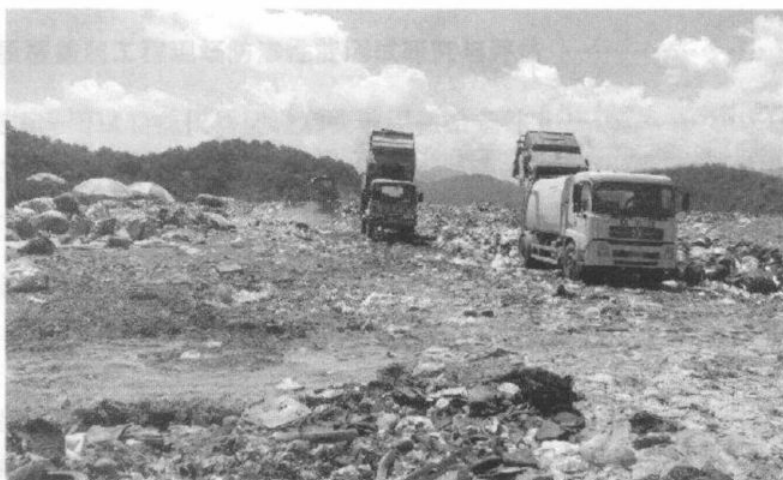
图 1.2 我国西南某填埋场垃圾填埋作业区垃圾倾倒现场
