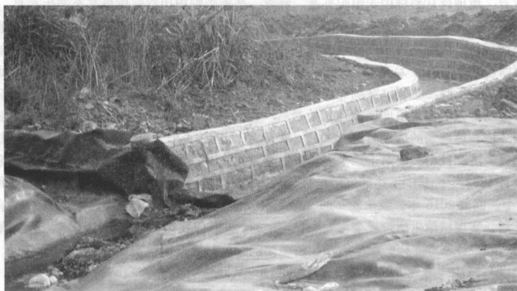
图 1.10 临时截洪沟与环库截洪沟的连接
