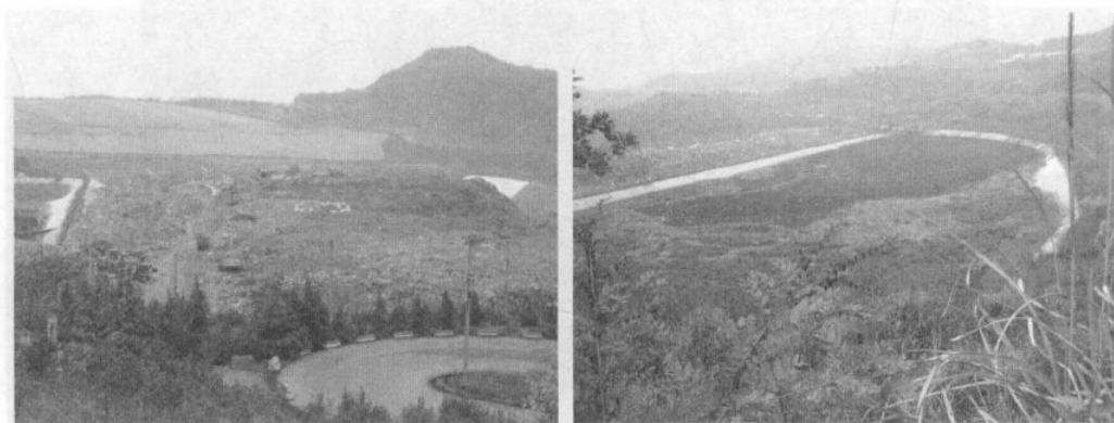
图 1.7 西南某省一垃圾填埋场的填埋作业区（左）和污泥处置坑（右）
