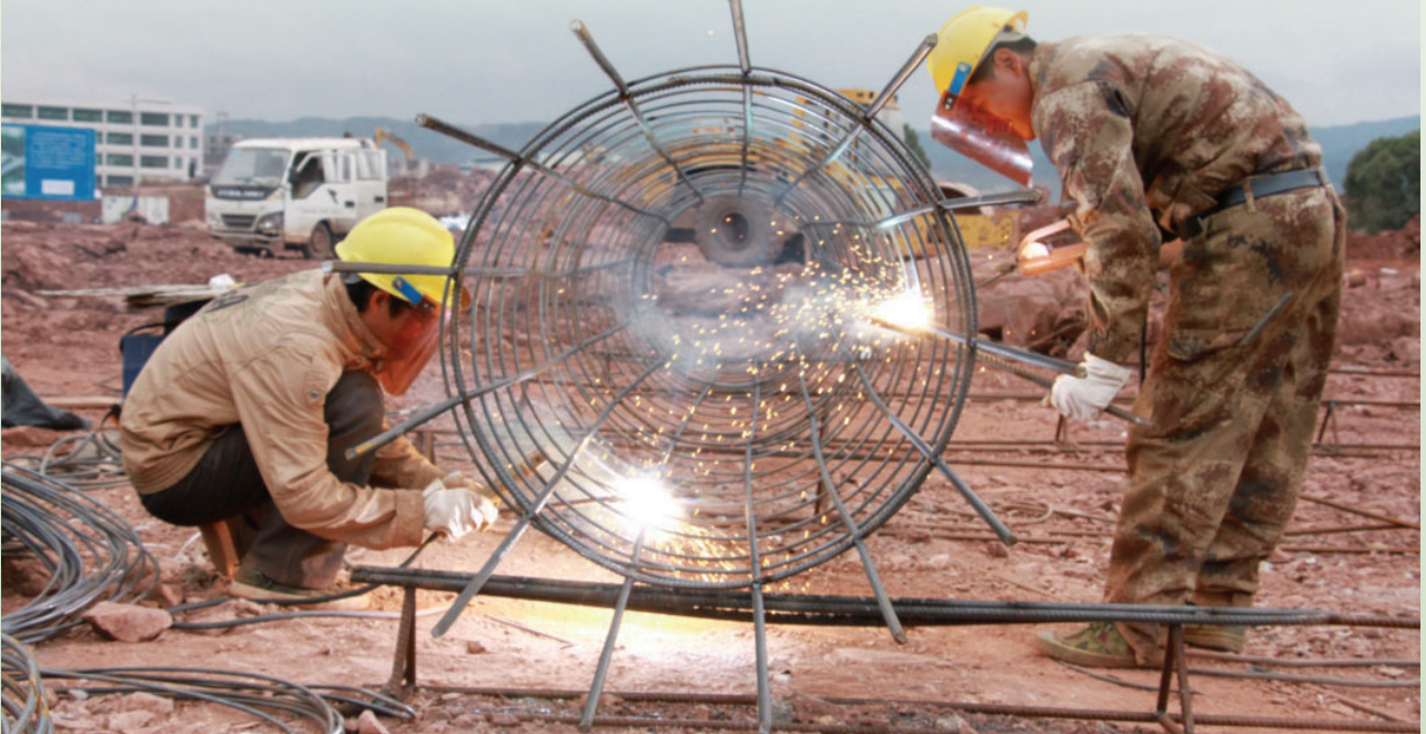
2016年12月13日，斯派纹奇体育用品有限公司厂房建设工人焊接钢圈 沈忠斌 摄
