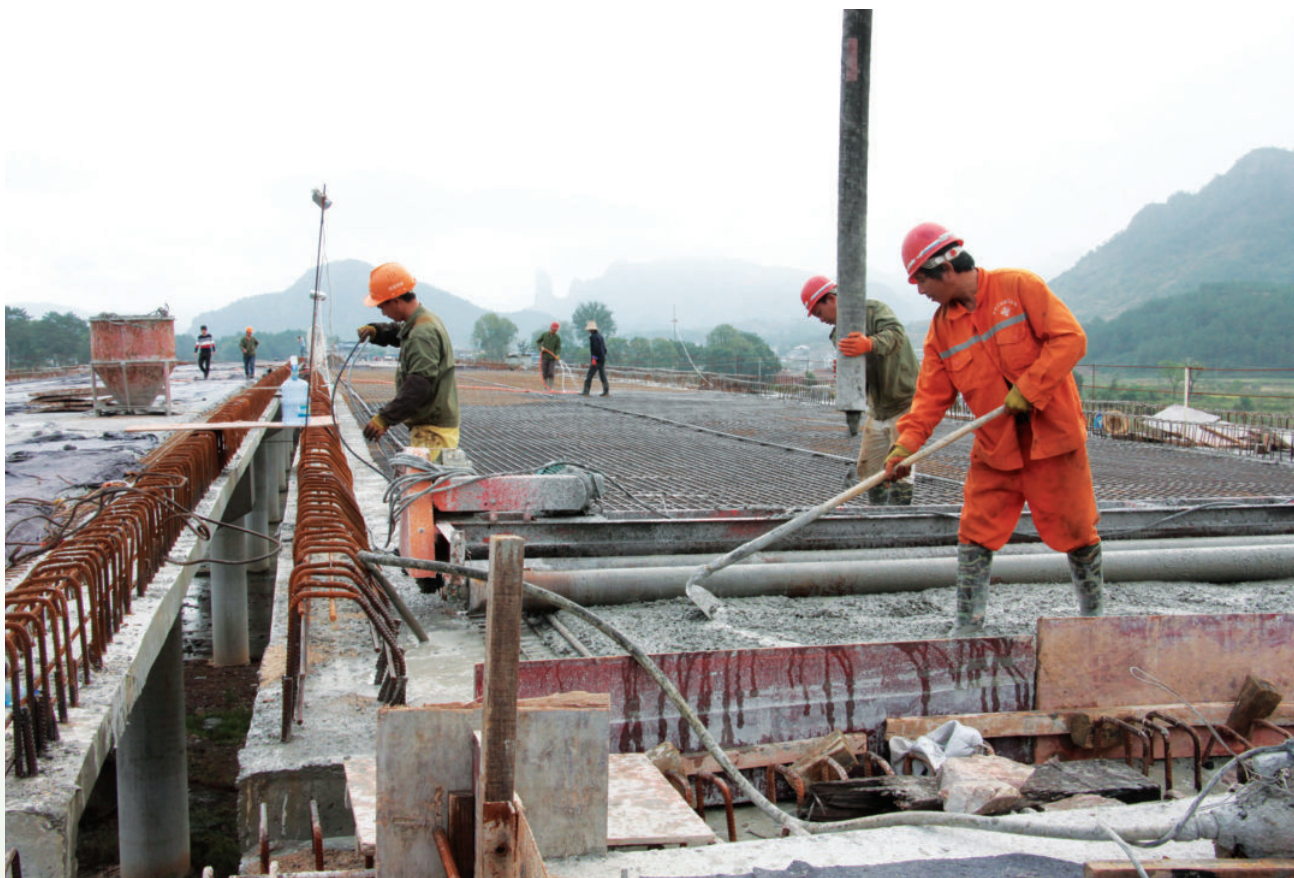
花园大桥建设现场 沈忠斌 摄
