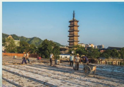
琴江廊桥桥面铺设 温礼明 摄
