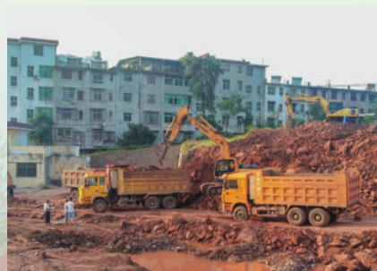
迎宾大道西延伸段工程于5月开工建设 温礼明 摄
