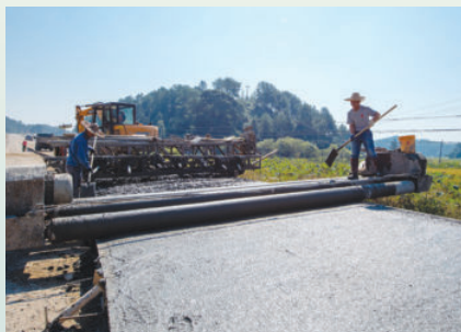
桐江至木兰公路施工现场 交通局 提供
