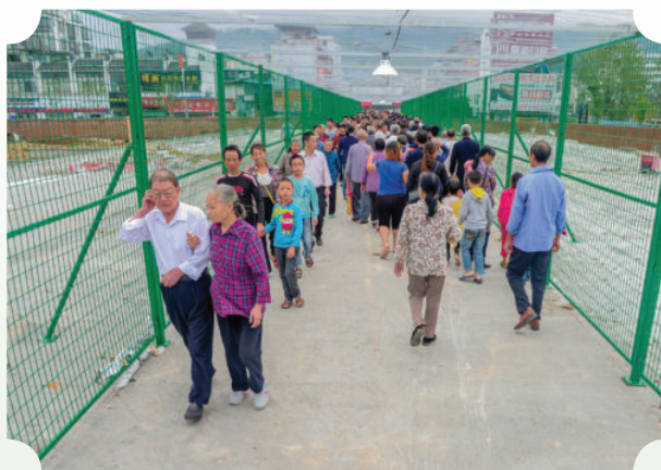
建设中的琴江廊桥开通人行便道 温礼明 摄
