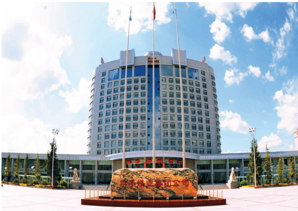
2012年4月，集团公司生产安全调度指挥中心建成投用
