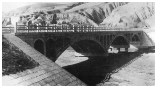
1978年环(县)甜(水)公路二十里沟口大桥建成通车。图为二十里沟口大桥全貌。
