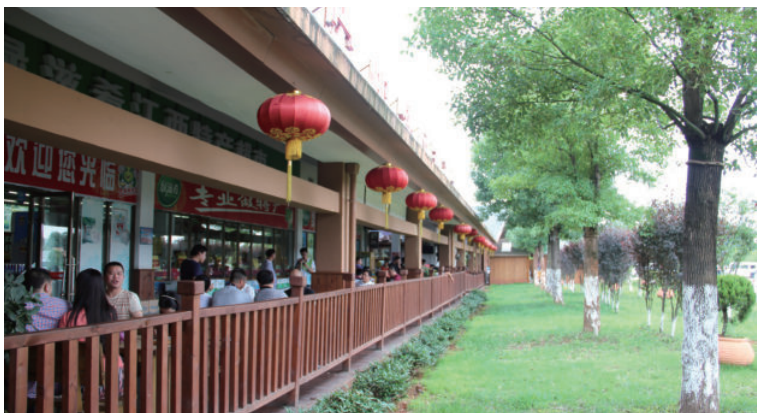
图6 江西省S69樟吉高速吉安服务区 综合楼木质外廊
