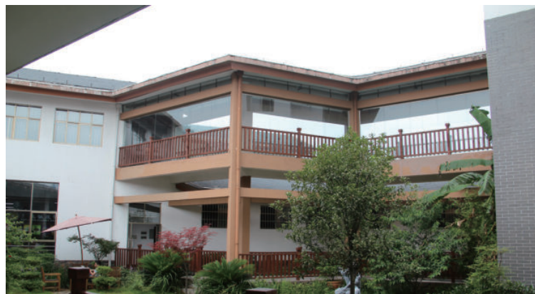
图7 江西省S69樟吉高速吉安服务区 综合楼构架连廊
