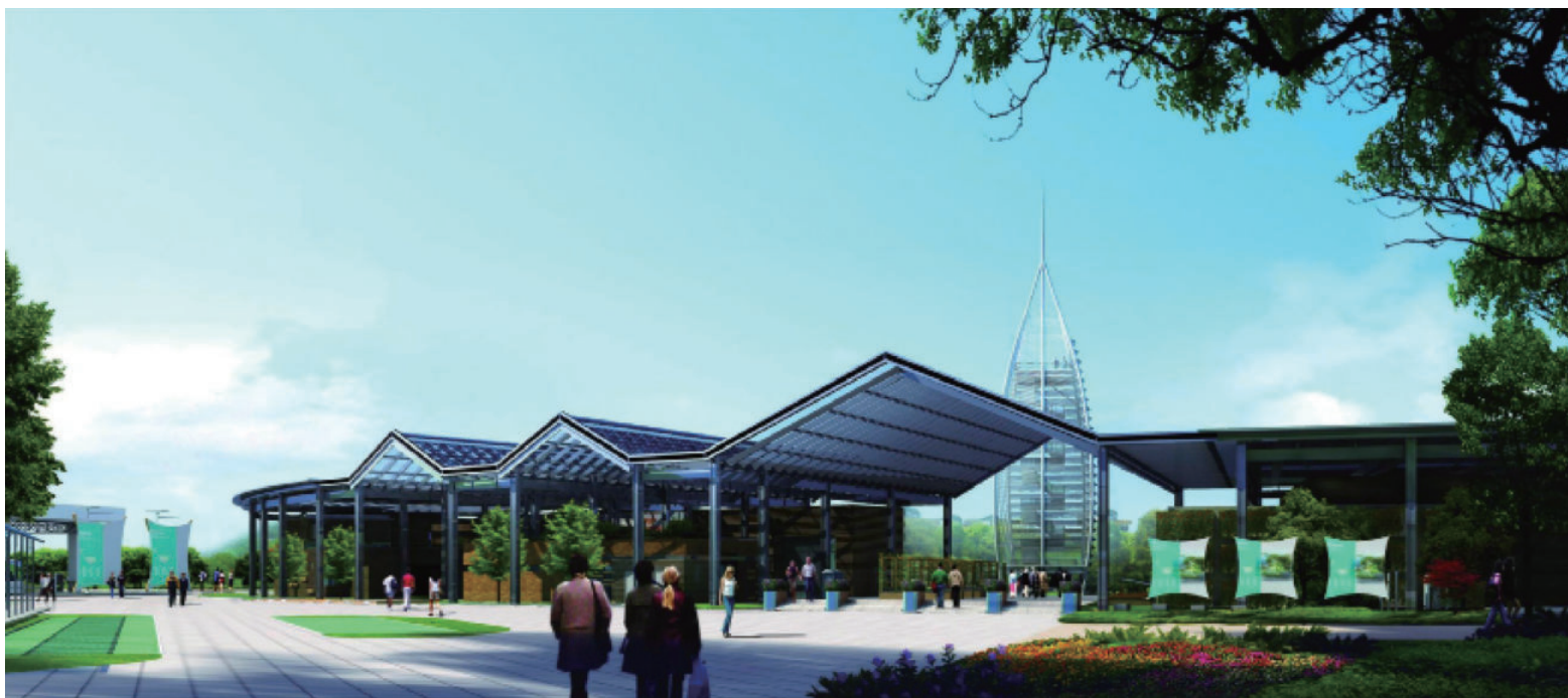
图2 江西省S30永武高速庐山西海服务区 综合楼
