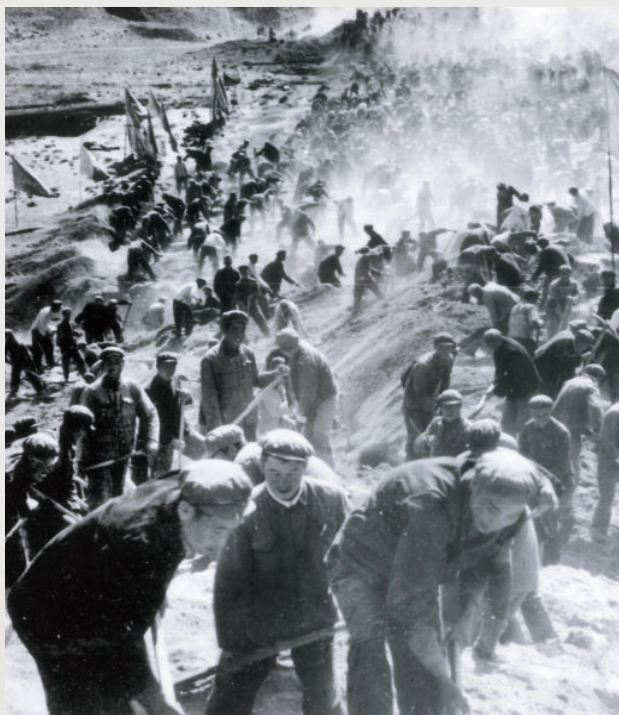
↑ 工程施工现场大干的场面
