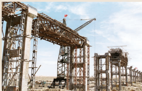
↑ 暗渠施工采用钢模台车
