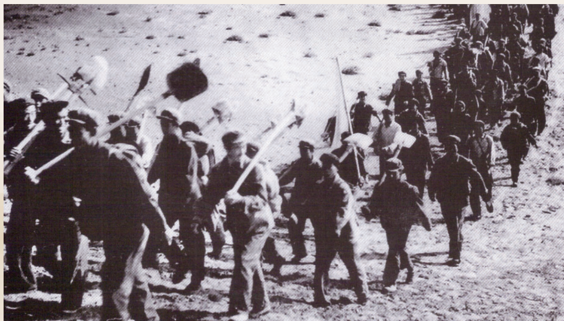
↑ 各路建设大军开赴工地
