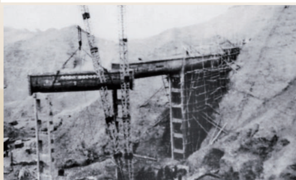
↑ 刀楞山芦阳沟渡槽吊装工地
