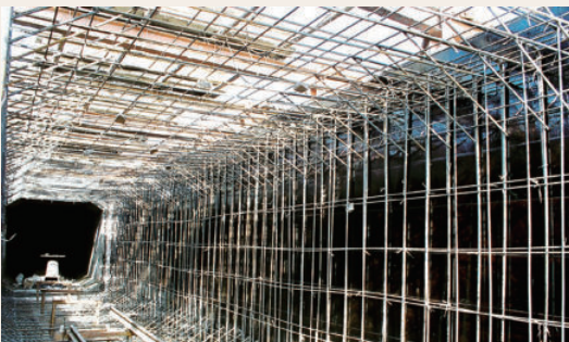
↑ 民调工程暗渠施工
