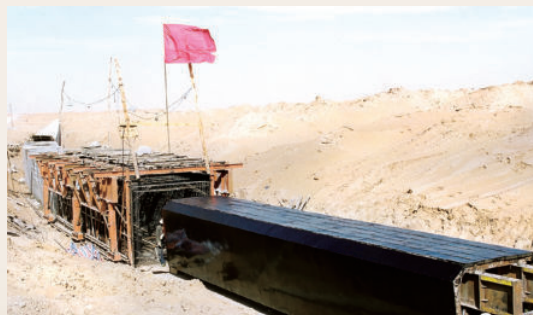
↑ 暗渠施工采用钢模台车
