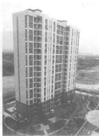
图 1-8 上海浦江保障房（国内应用范围最广泛的剪力墙结构装配式混凝土建筑）
