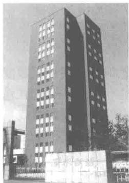
图 1-2 装配式混凝土结构建筑——沈阳丽水新城（中国最早的一批装配式建筑）
