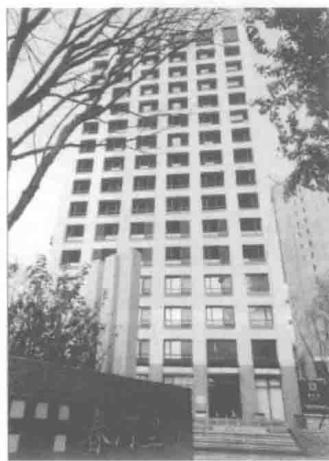
图 1-7 沈阳万科春河里 17 号楼（中国最早的高预制率框架结构装配式混凝土建筑）
