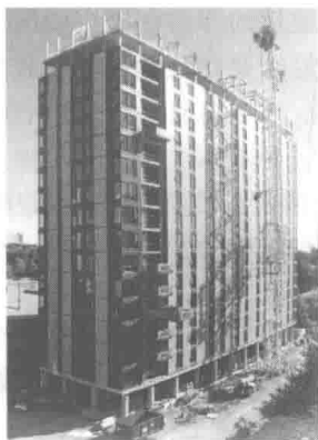
图 1-4 世界最高的装配式木结构建筑（温哥华 UBC 大学学生公寓楼，高 53m）
