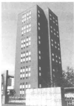
图 1-2 装配式混凝土结构建筑——沈阳 丽水新城（我国最早 的一批装配式建筑）
