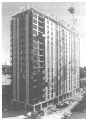
图 1-4 世界最高的装配式木 结构建筑（温哥华 UBC 大学 学生公寓楼，高 53m）
