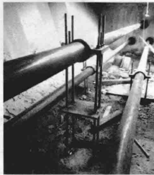
图 1-8 体外索减振器安装
