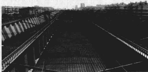
b 临时支撑支架照片
