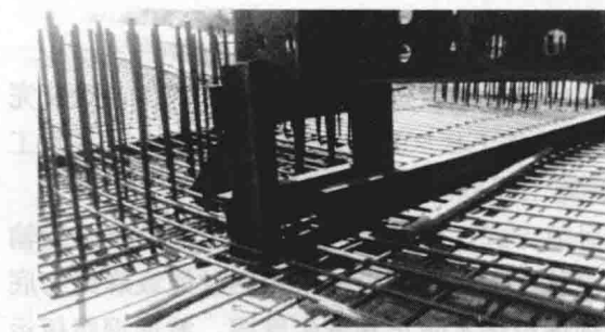
图 1-2 波形钢腹板简易支架
