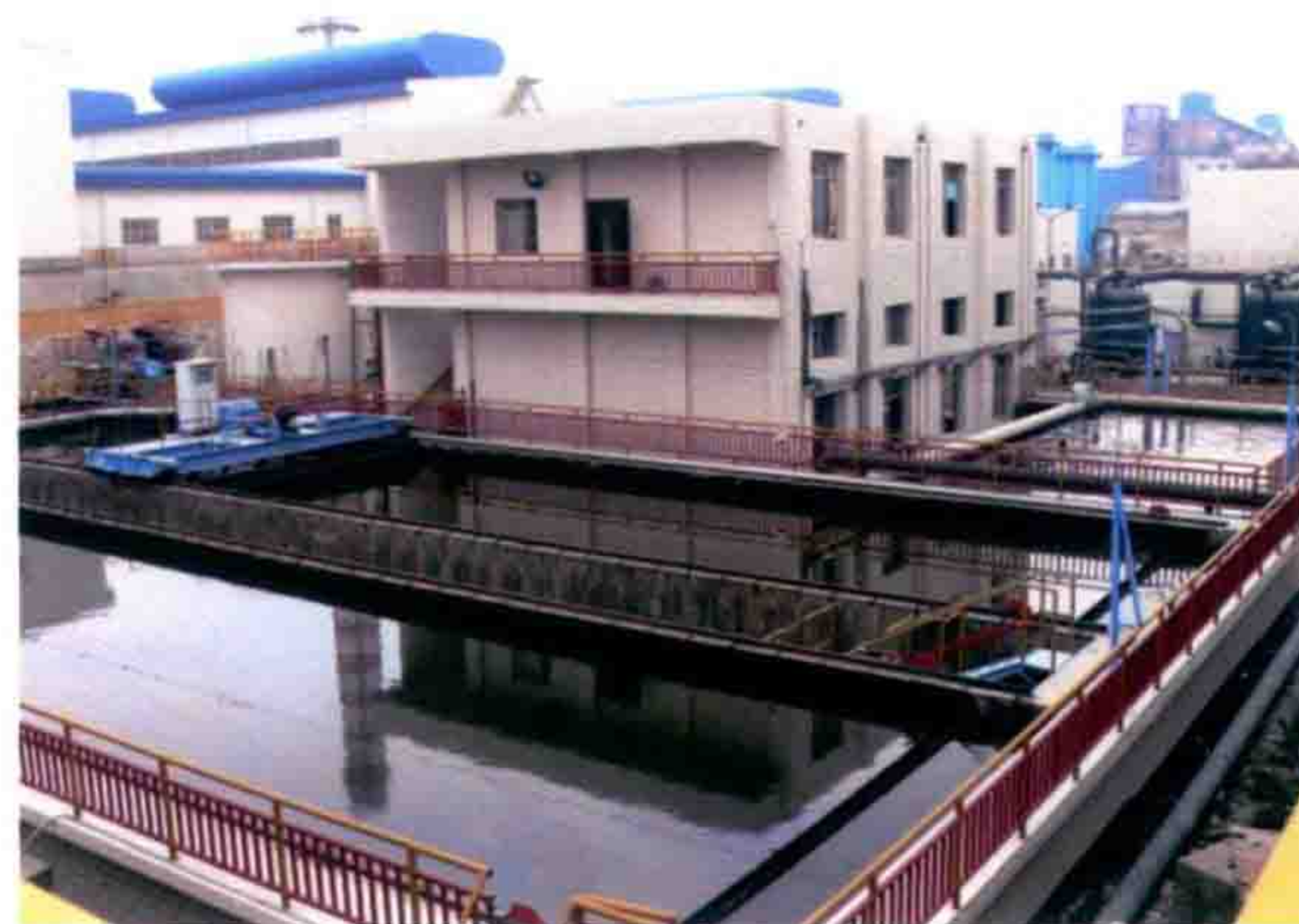
2006年9月，运行中的贵州铝厂碳素废水处理系统
