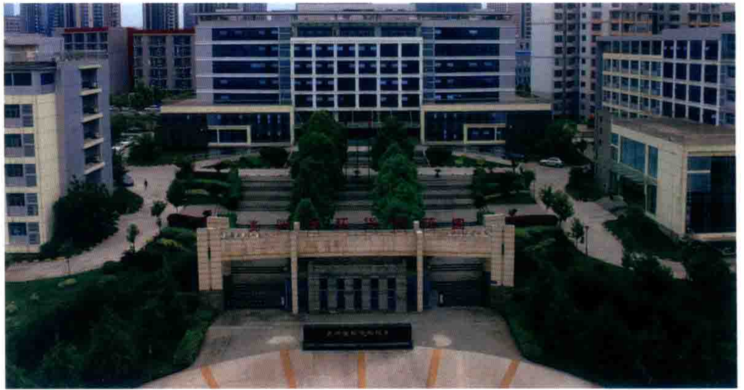
贵州省环保科技园 全貌（2010年）
