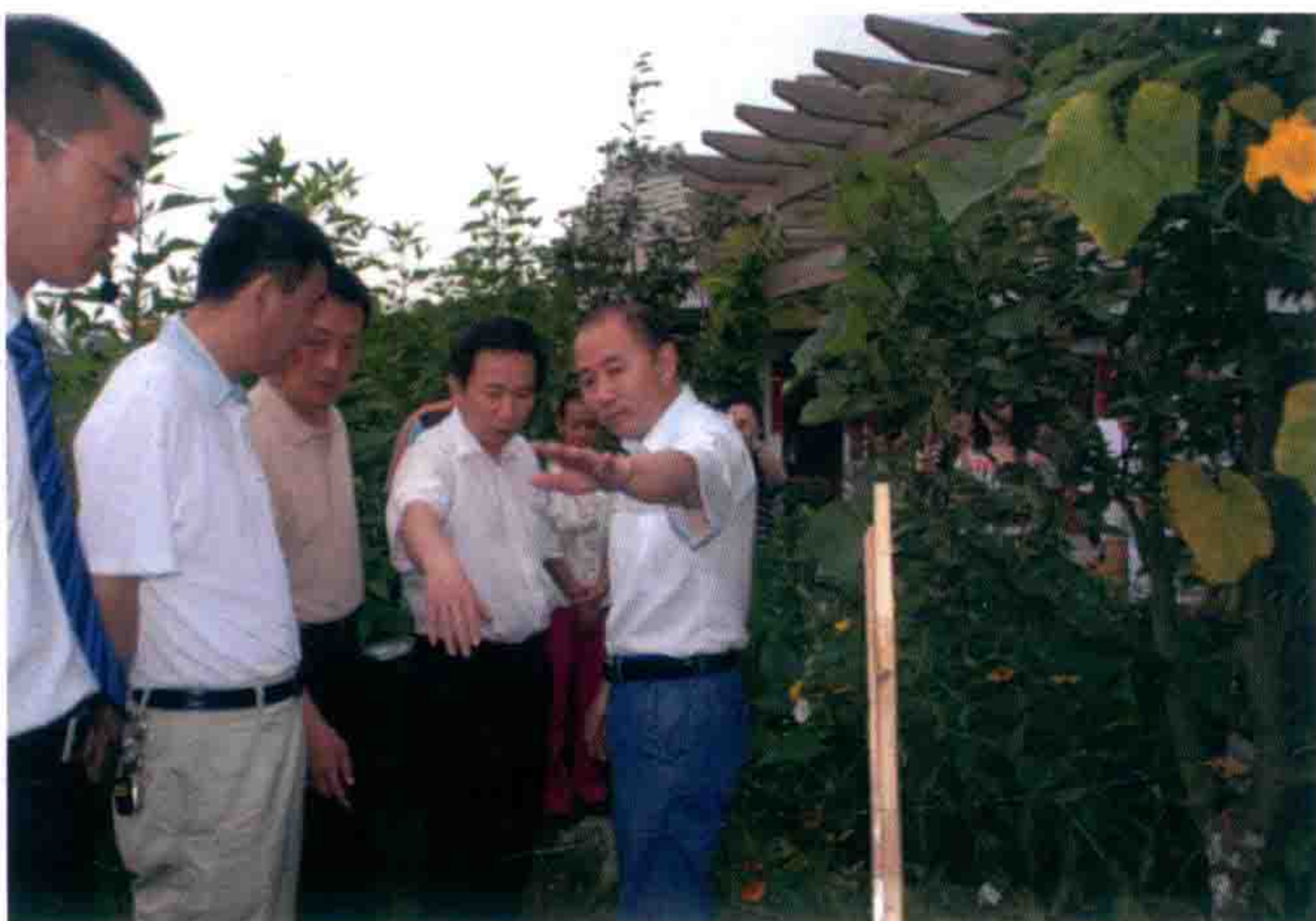
2010年7月31日，环保部副部长李干杰（右二）考察贵州德润环保产业有限公司建造的污水处理设施
