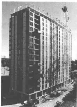
图 1-4 世界最高的装配式木结构建筑（温哥华 UBC 大学学生公寓楼，53m）
