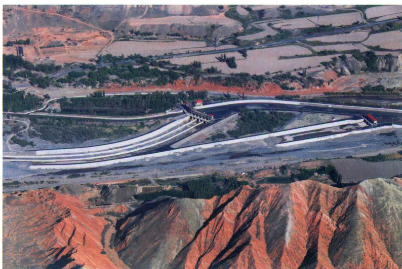
玛纳斯河梯级水电站 分水渠系统
