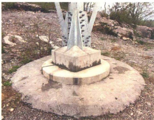
图1-5-2 基础回填土标准工艺
