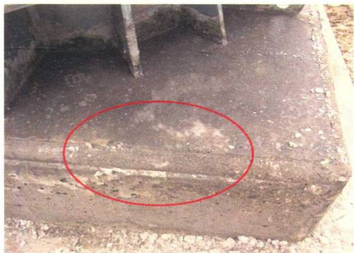
图1-1-1 基础保护帽脱皮破损
