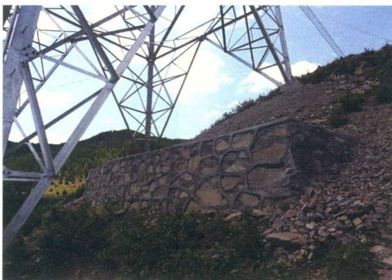
图1-6-2 杆塔塔脚正常状态
