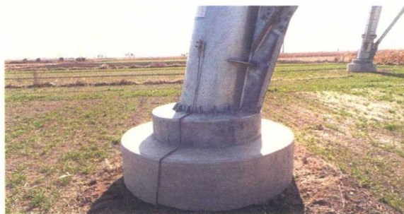
图1-3-2 基础立柱面标准工艺
