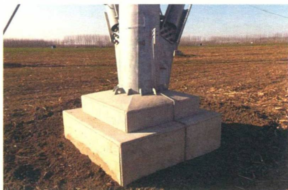
图1-2-2 基础保护帽散水坡度标准工艺
