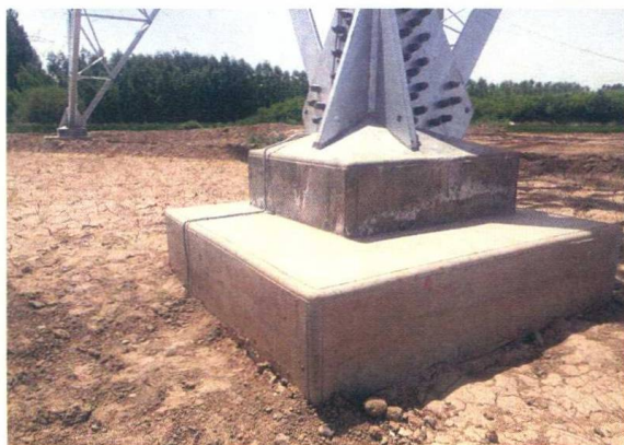
图1-4-2 基础立柱面标准工艺
