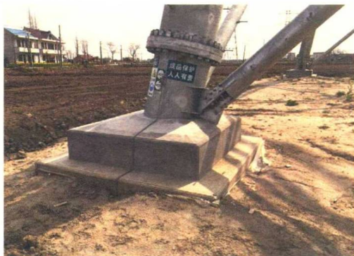
图1-1-2 基础保护帽标准工艺
