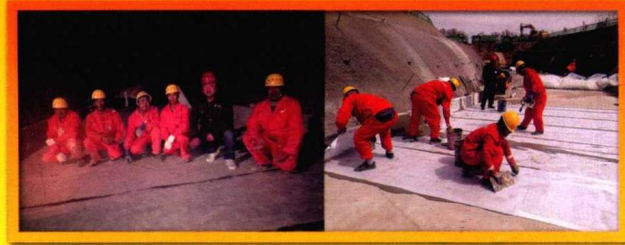
北京世界园艺博览会园区地下综合管廊工程
