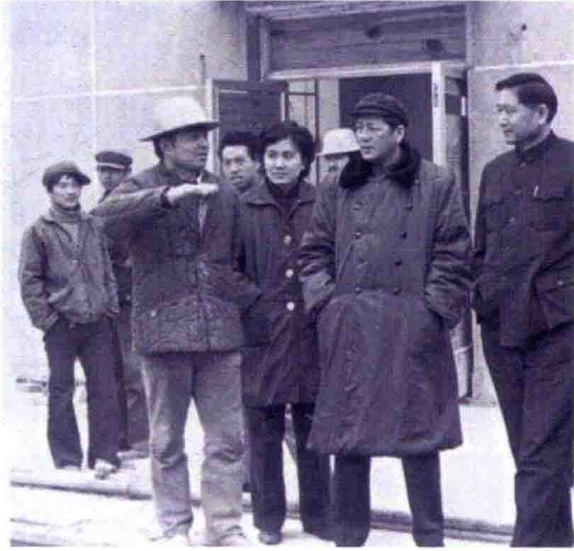
1984年1月，中共中央政治局委员倪志福（右二）考察乌江渡水电站。
