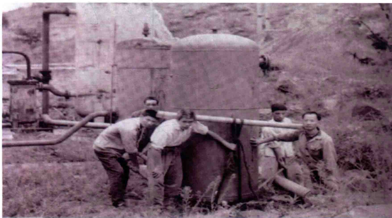
三线建设者在没有大型机械设备的情况下，人工搬运设备。
