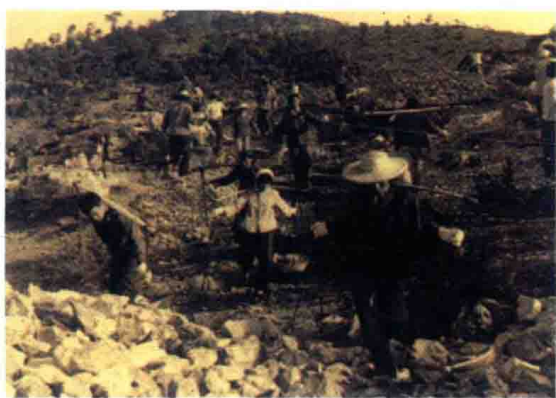
○六一基地一建设工地
