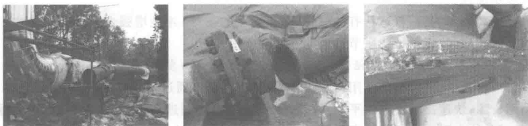
图2 某高温高压蒸汽管线用补偿器
