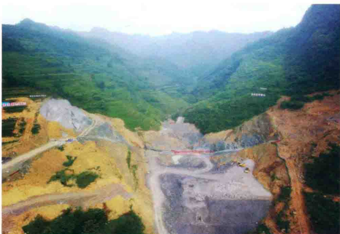
2017年，建设中的兰草湾水库
