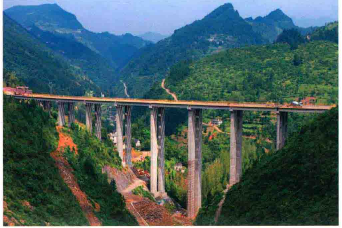
务川至德江高速公路务川段，建设中的徐家坝大桥
