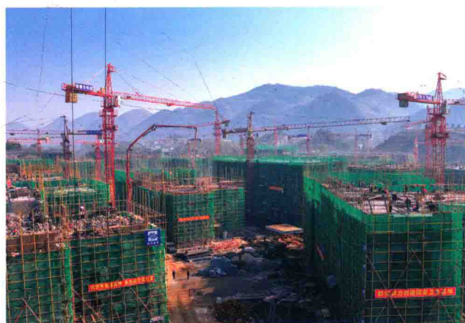
12月22日，务川自治县移民安置点（大坪街道大坪社区）第四、第五期工程施工现场图
