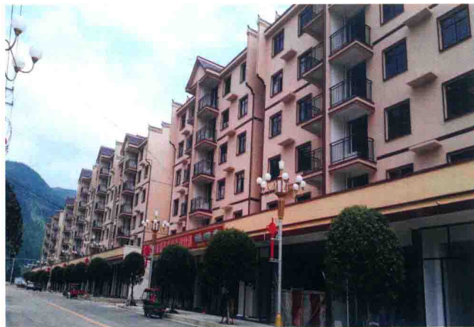
2017年，黄都镇移民安置房小区
