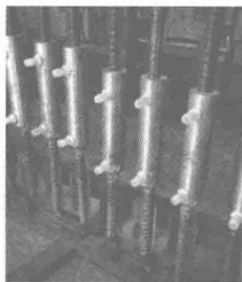
图 1-6 钢筋套筒灌浆连接
