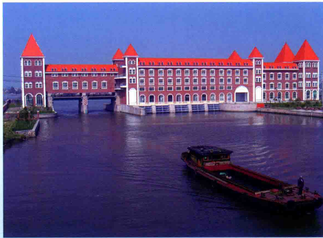
嘉兴城市防洪工程
