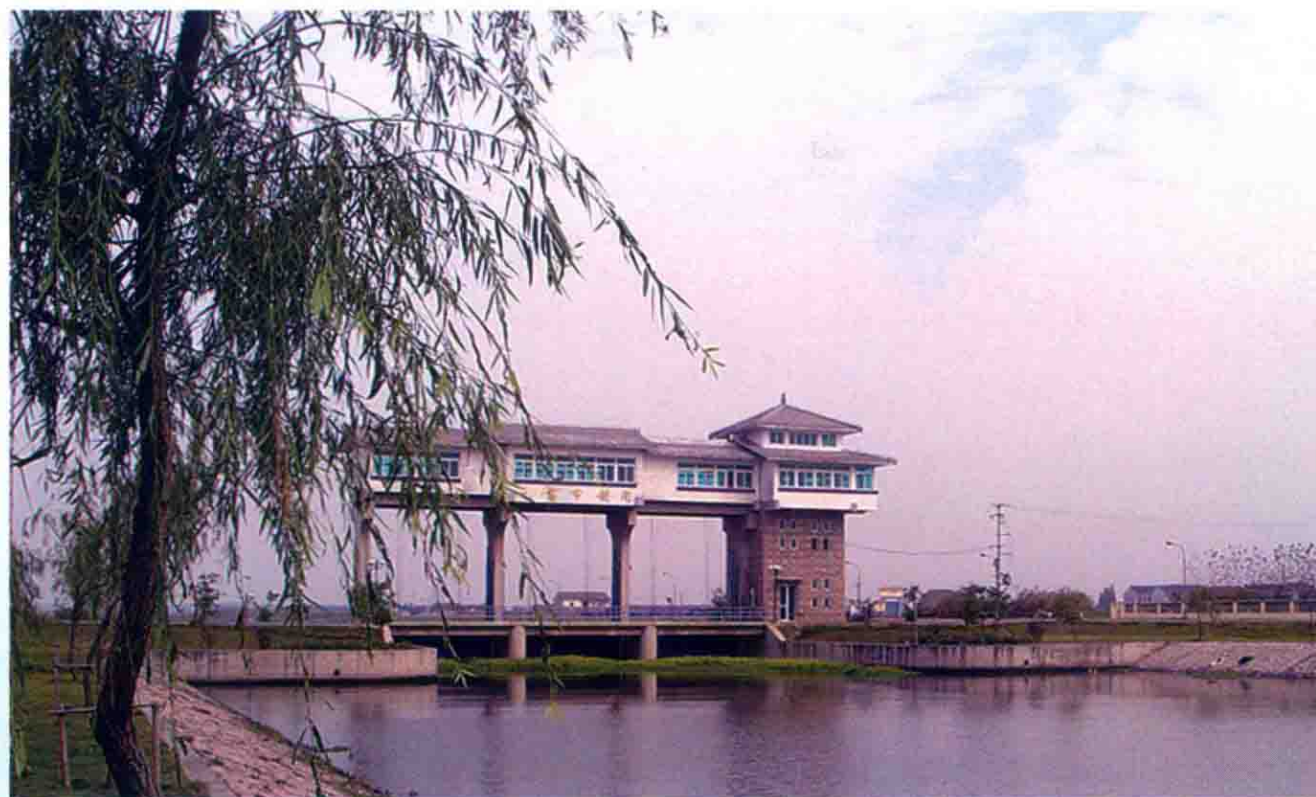
扩大拦路港疏浚泖河及斜塘工程——元荡节制闸
