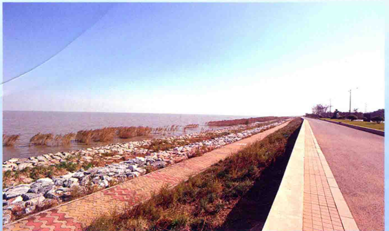
环湖大堤工程
