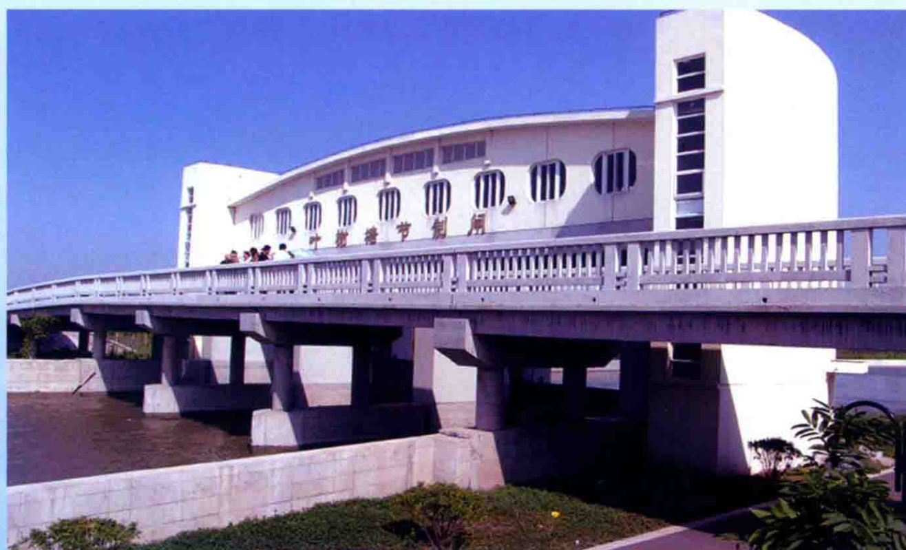
黄浦江上游干流防洪工程——叶榭塘水利枢纽
