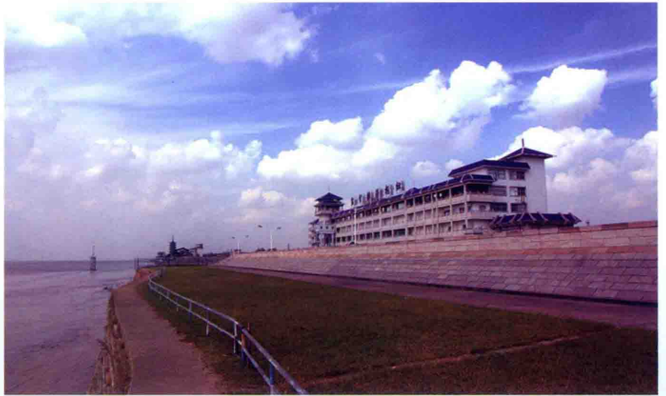
杭嘉湖南排后续工程——盐官下河水利枢纽
