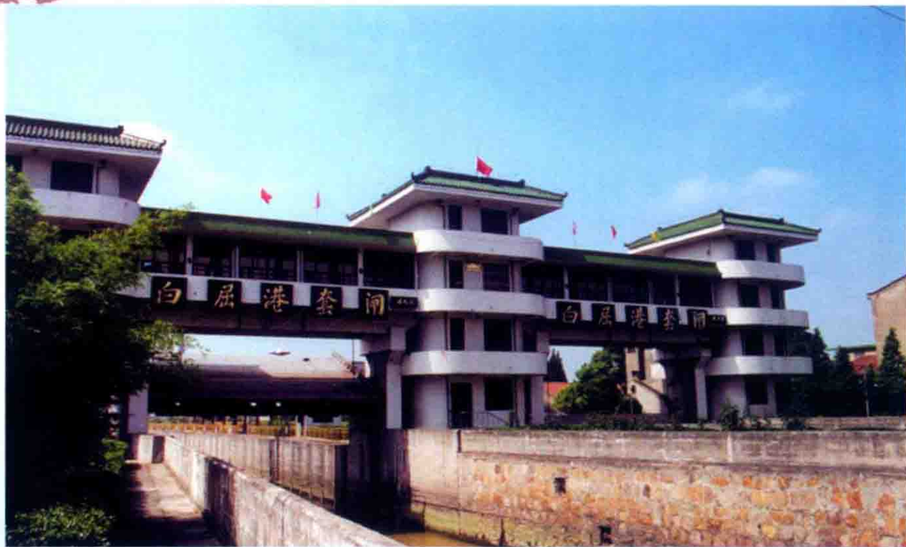
武澄锡引排工程——白屈港水利枢纽
