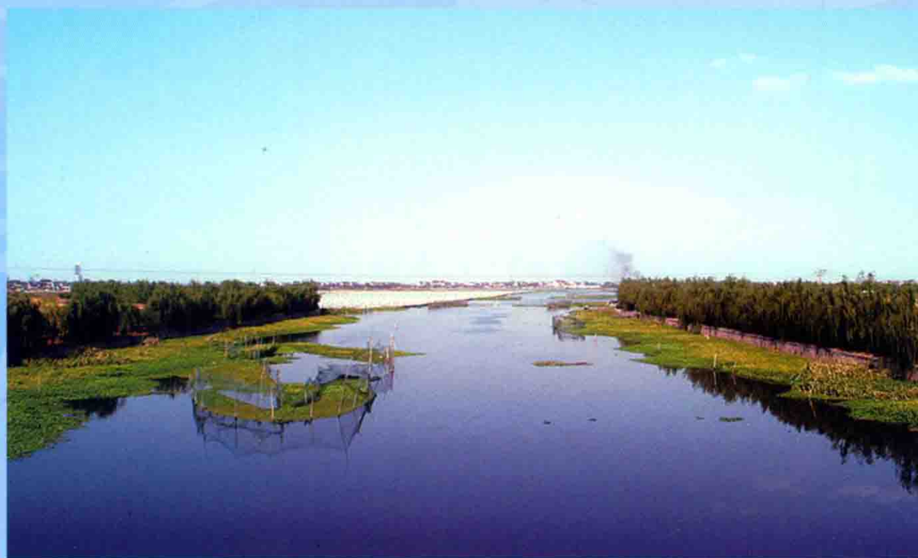
杭嘉湖北排通道工程
