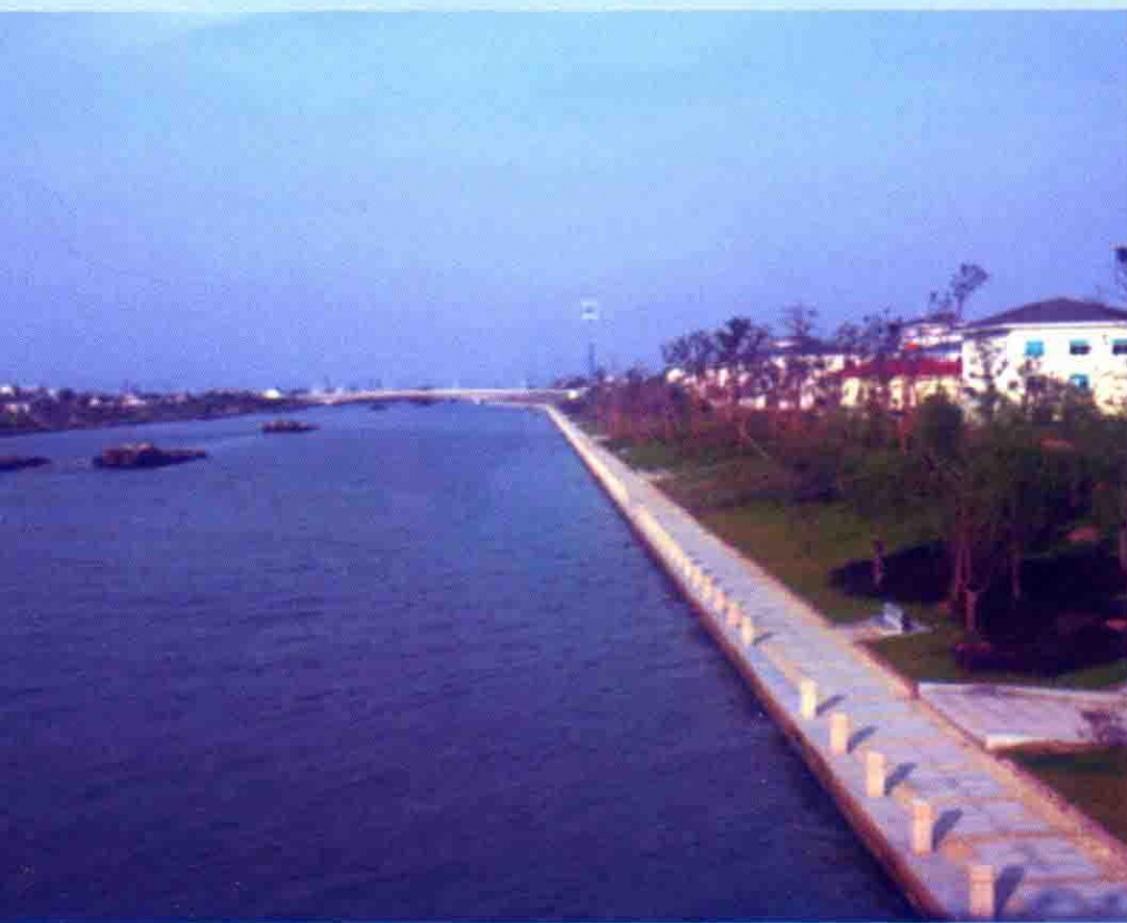
湖州城市防洪工程
