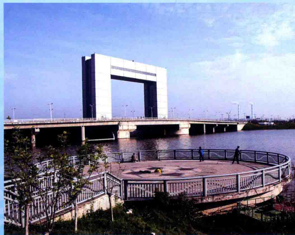
镇江城市防洪工程（镇江市水利局 提供）
