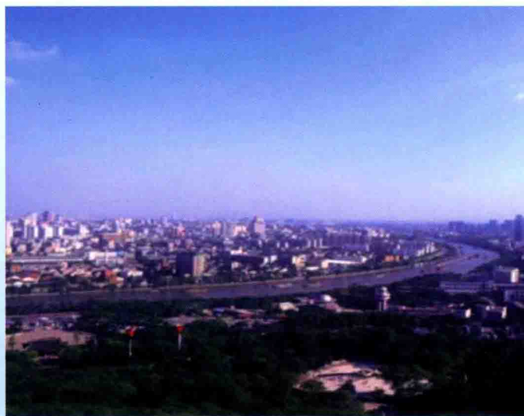
无锡城市防洪工程
