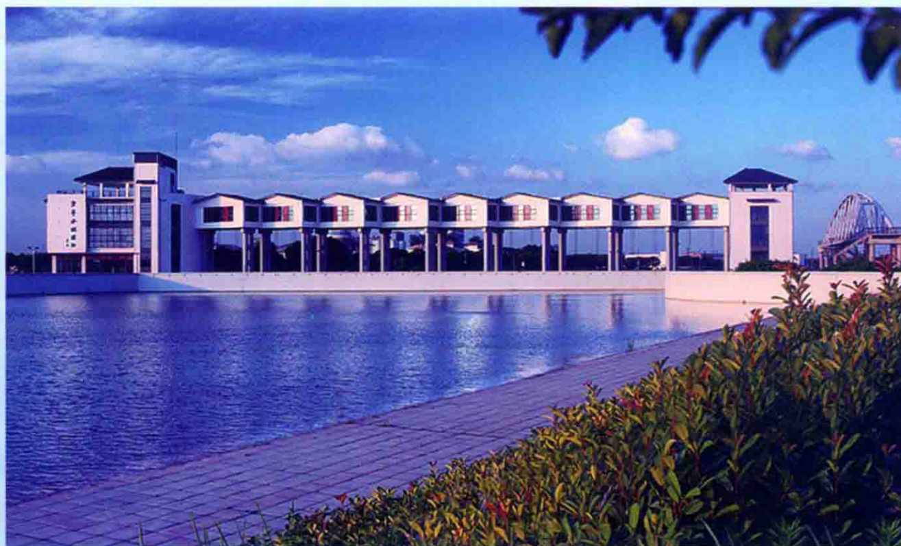
望虞河工程——望亭水利枢纽（吴浩云 摄）
