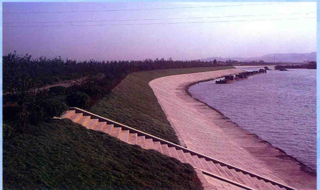
东西苕溪防洪工程——东苕溪导流东大堤
