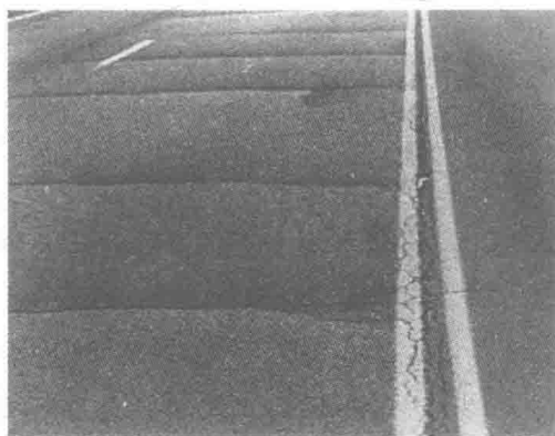
图 1.4 温度应力产生的破坏
