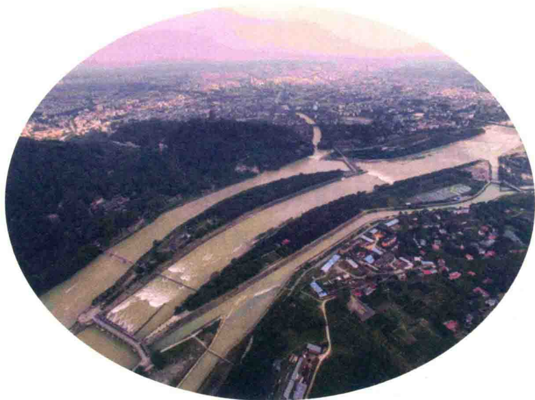
都江堰水利工程
