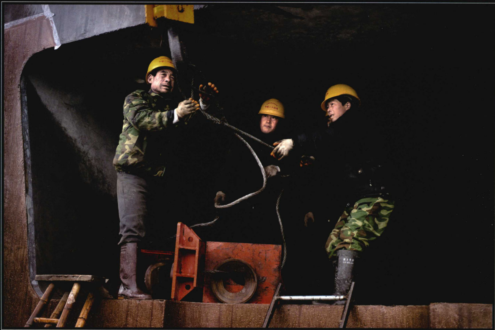
箱梁吊装准备
