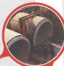
进行隧道防水的 南水北调配 套工程
