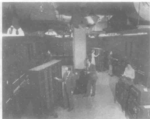
图 1-6 世界上第一台电子计算机 ENIAC
