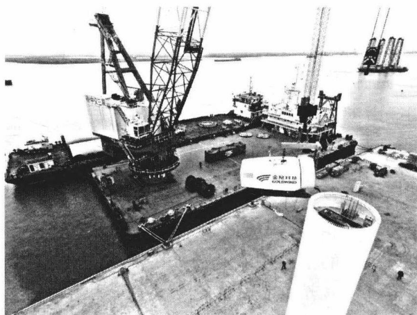
图 1-2 运输驳船在码头进行机组塔架和机舱的装载
