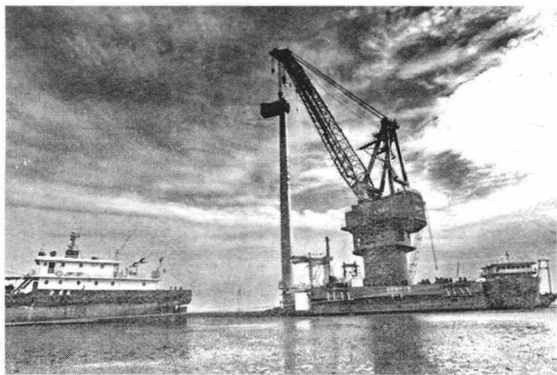
图 1-4 江苏省南通潮间带单桩风电机组基础设计与施工
