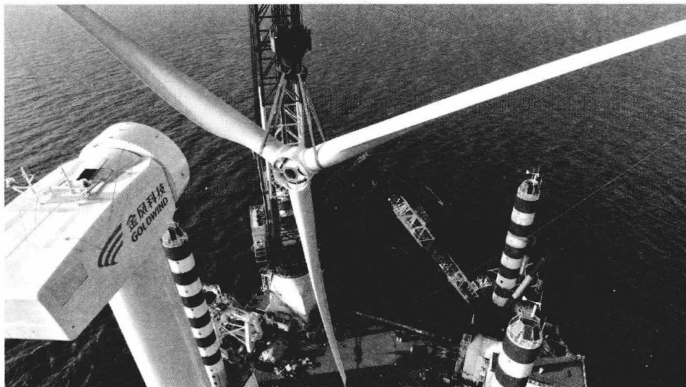
图 1-7 安装船进行风轮的吊装
