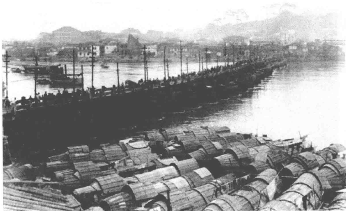
改造前的福州万寿桥（今解放大桥）。（摄于1928）
