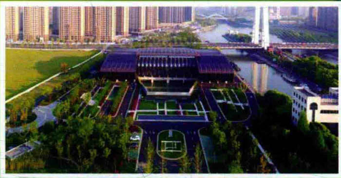
▲ 扩大杭嘉湖南排杭州三堡排涝工程 (中国建设工程鲁班奖)
