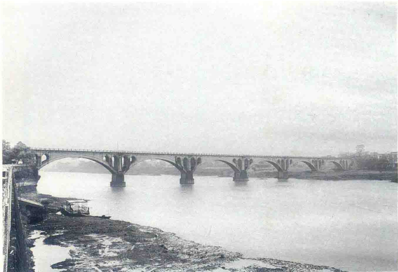
▲ 湘东铁路攸县洙水大桥
