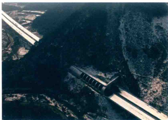
图 2.6 通透肋式连拱隧道实景图(南山隧道)
