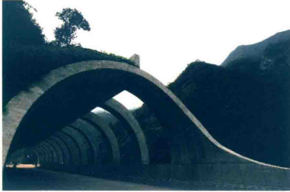
图 2.3 龙瀑隧道——通透肋式单洞隧道
