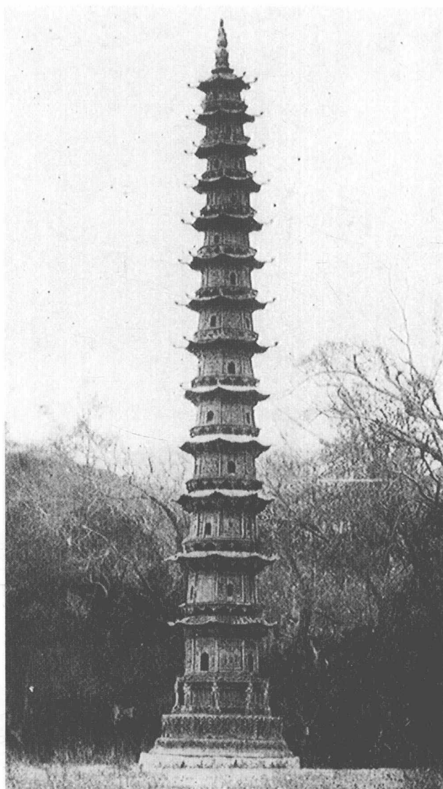
插图 11. 现存最古老的铸铁塔(1061 年),位于湖北省当阳的玉泉寺。
