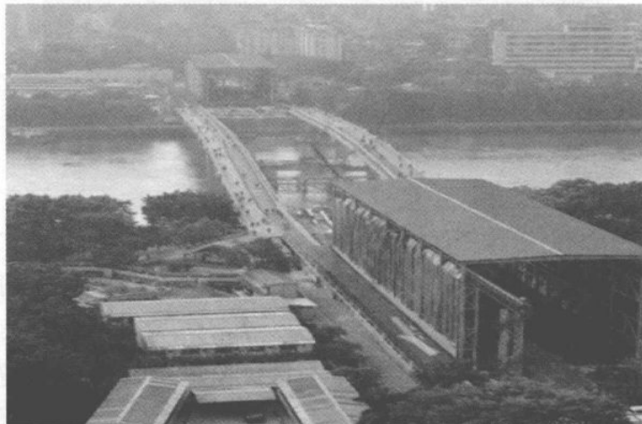
图 1.26 边跨钢桁梁在两岸引桥桥面活动厂房大修
