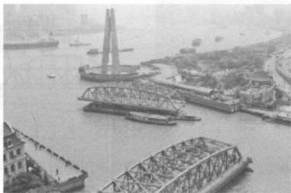
图 1.18 驳船浮力顶升法移桥
