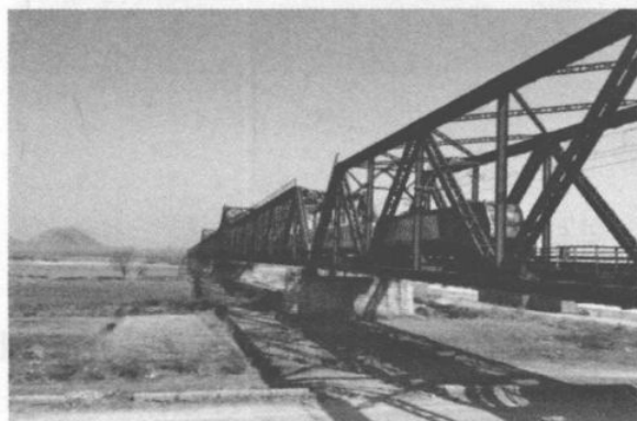
图 1.9 涿口黄河铁路桥
