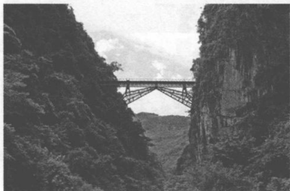
图 1.6 云南五家寨铁路桥
