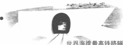
世界海拔最高铁路隧道 风火山隧道 海拔4905米
