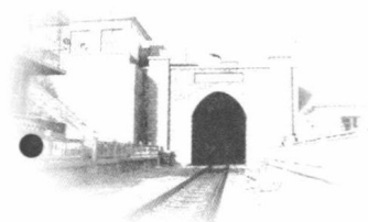
20世纪70年代修建的 关角隧道 海拔3692米
