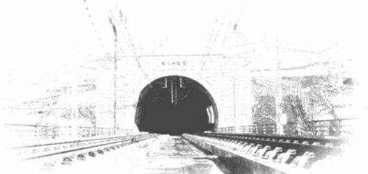
世界海拔最高高铁隧道 祁连山隧道 海拔3607米
