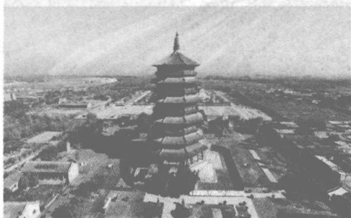
图 1-1 山西应县木结构古塔
