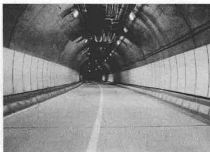
图 1-1-2 现代化的隧道
