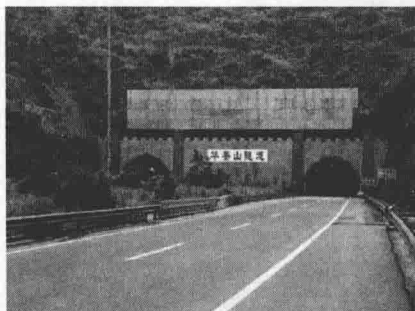
图 1-1-4 四川华蓥山隧道
