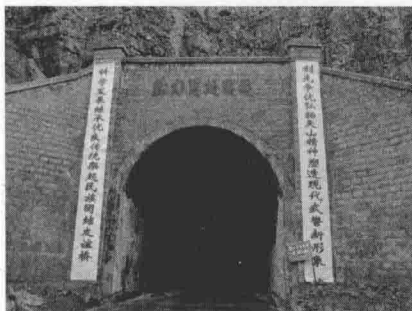
图 1-1-3 新疆铁力买提隧道
