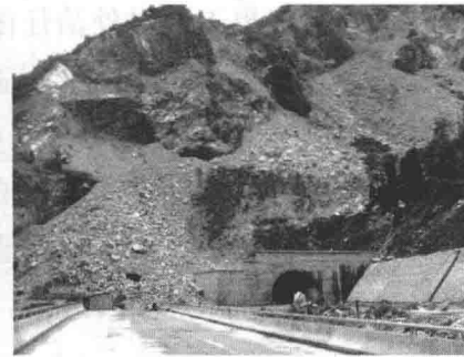
图 1-2-6 隧道震害
