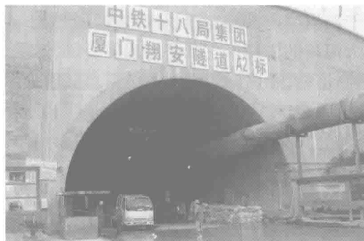
图 1-13 翔安海底隧道洞口
