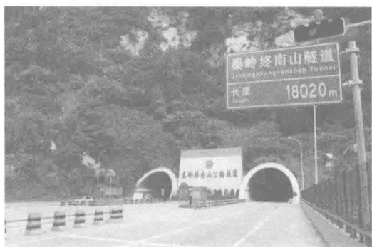
图 1-4 秦岭终南山公路隧道洞口
