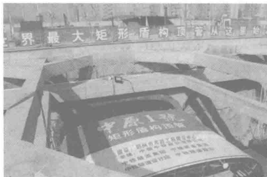
图 1-12 红专路隧道盾构施工始发
