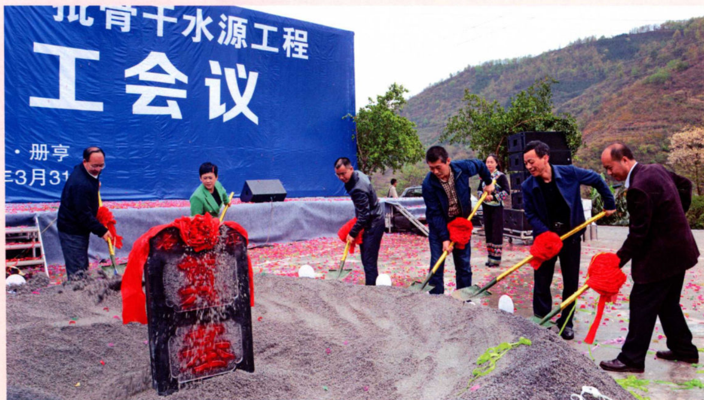
2017年3月31日，贵州省第一批骨干水源项目集中开工仪式在丫他镇洛艾水库工程建设项目现场举行，副省长刘远坤，州委副书记、州长杨永英等省州领导出席开工仪式并为洛艾水库奠基
