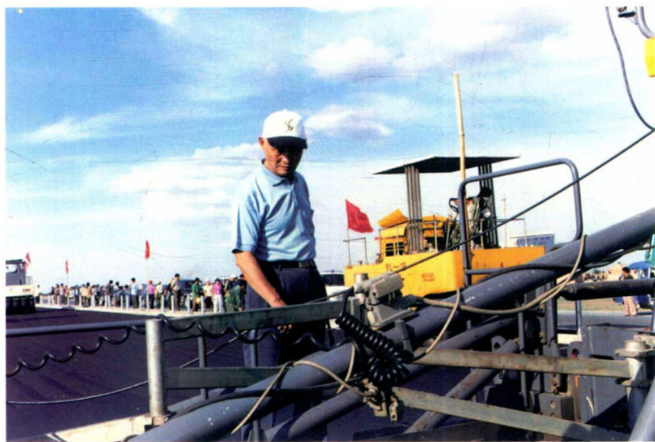
2002年站在摊铺机上察看沥青混合料摊铺前后的情况
