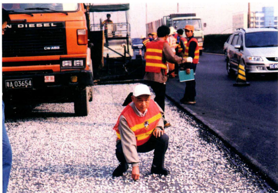
2003年广深高速公路大修时赴工地实地察看施工公司铺的黏结防水层
