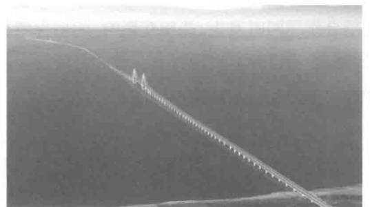
b)杭州湾大桥
