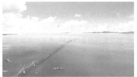
d)港珠澳大桥
