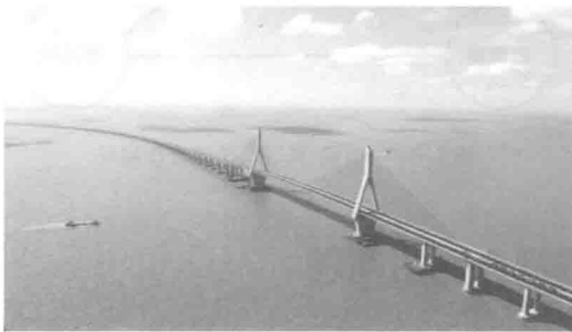
a)东海大桥
