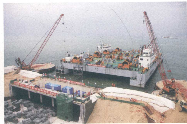
2013年5月6日，首节沉管E1完成安装
