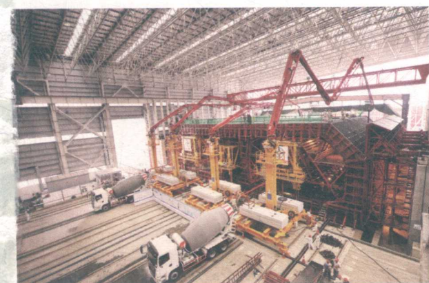
2012年8月7日，首节沉管完成混凝土浇筑
