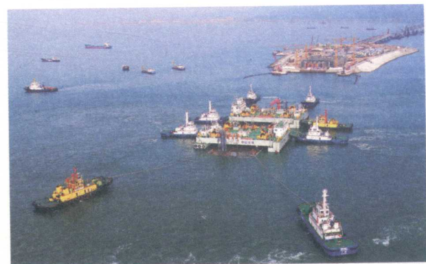
2016年10月8日，首节曲线沉管E33浮运安装
