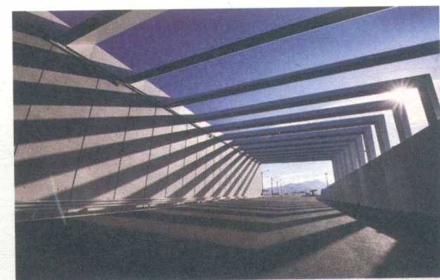
2016年12月24日，东人工岛减光罩安装完成
