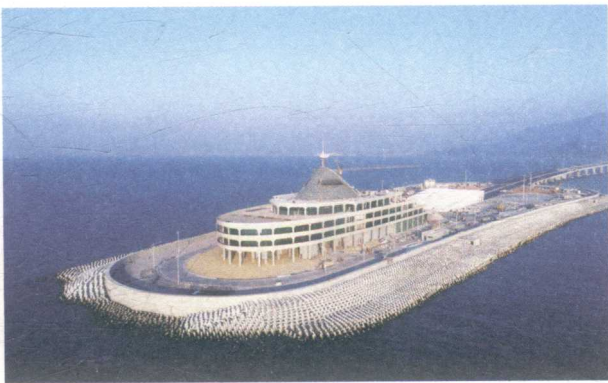
2017年8月31日，东人工岛主体结构正式封顶
