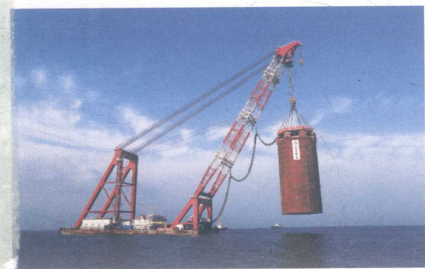
2011年5月15日，西人工岛首个钢圆筒顺利振沉
