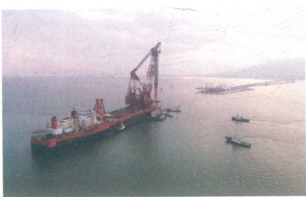
2017年5月2日，“振华30”实施最终接头安装
