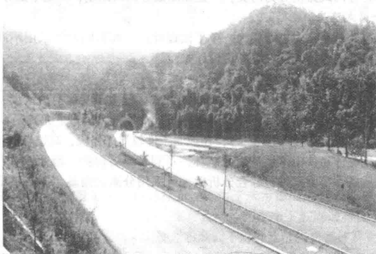
图 1-6 斜坡地段分离式路基
