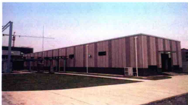
图 1-2 变电站装配式建构筑物外观（二）
