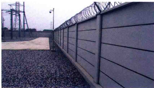
图 1-3 变电站装配式围墙
