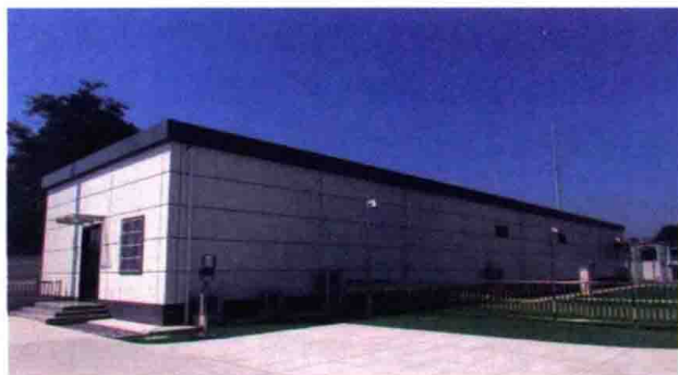
图 1-1 变电站装配式建构筑物外观（一）
