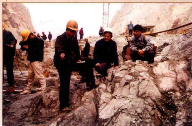
在三峡工程临时船闸工地现场 (1996.3)
