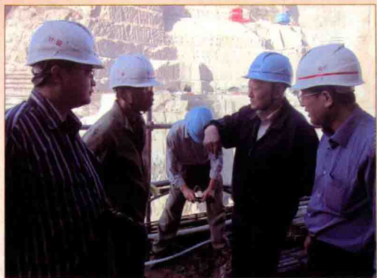
在乌东德水电站工地现场研讨 (2017.12)
