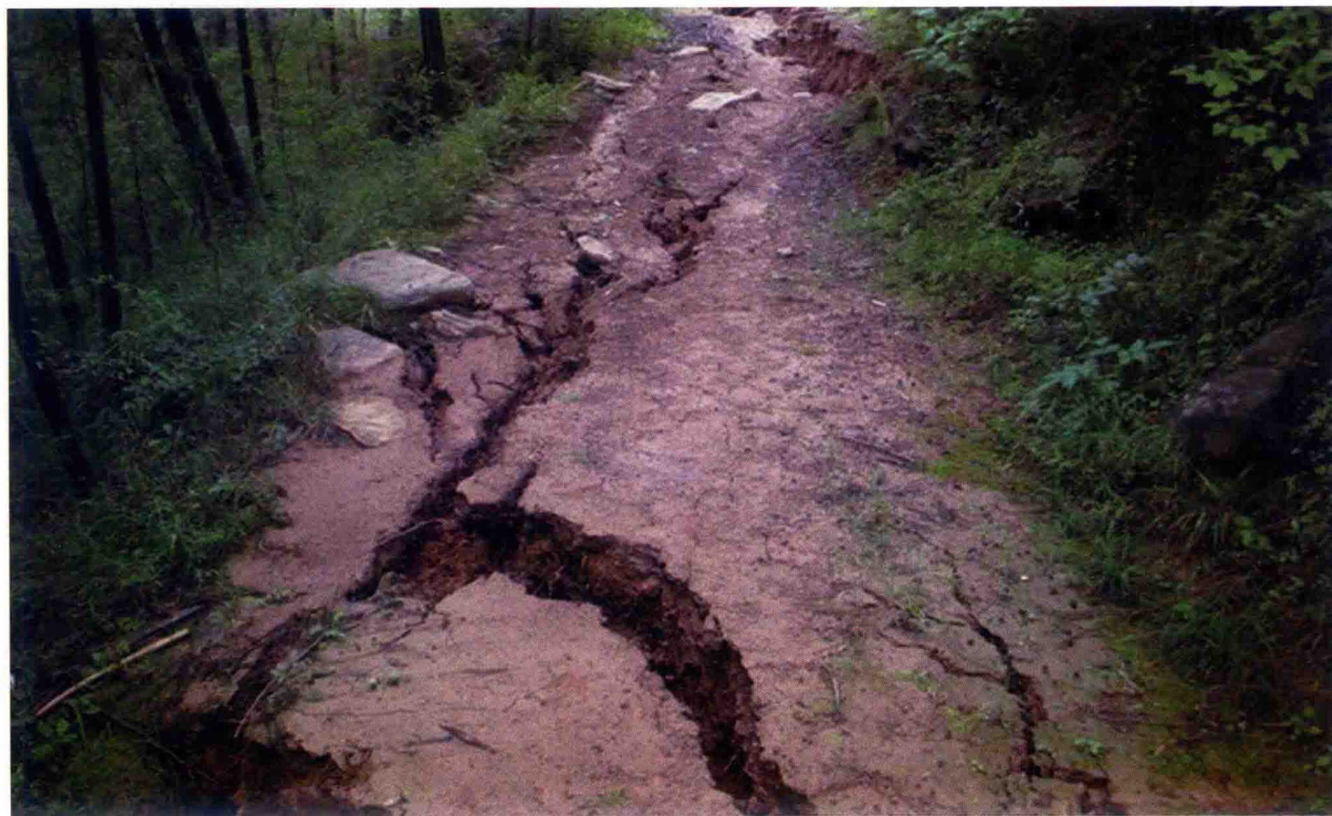
毛坝乡宝桥村地裂
