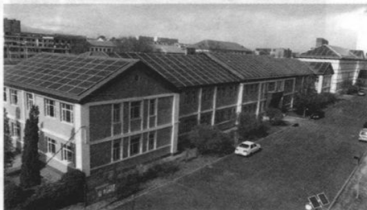
图 1-7 太阳能光伏建筑一体化
